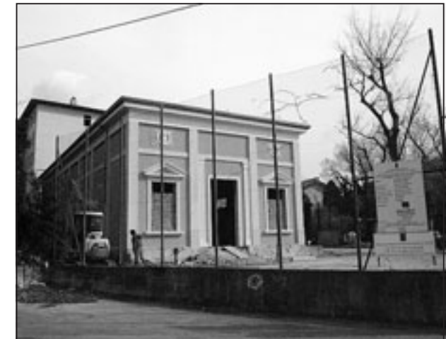
Il ricreatorio Nordio in ristrutturazione
