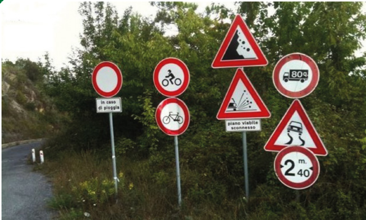
Improvvisazione per carenza di competenze: numero eccessivo di segnali in circa 10 m
