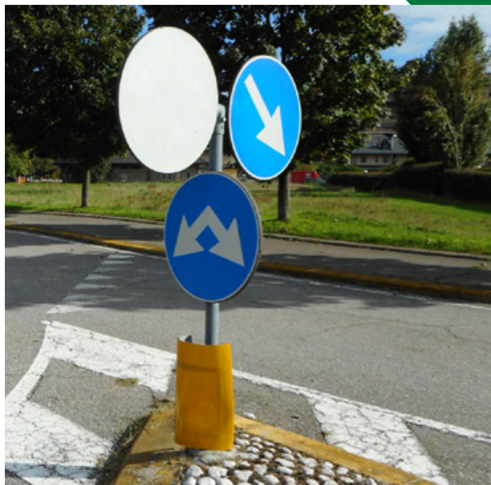
Assenza di manutenzione: segnaletica sbiadita, illeggibile e uso improprio del segnale fig. II 83, errato posizionamento
