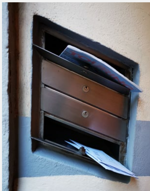
Cassette vista interno cm 25x30, apertura cm 5,5 dov'è possibile imbucare facilmente un busta formato A3
