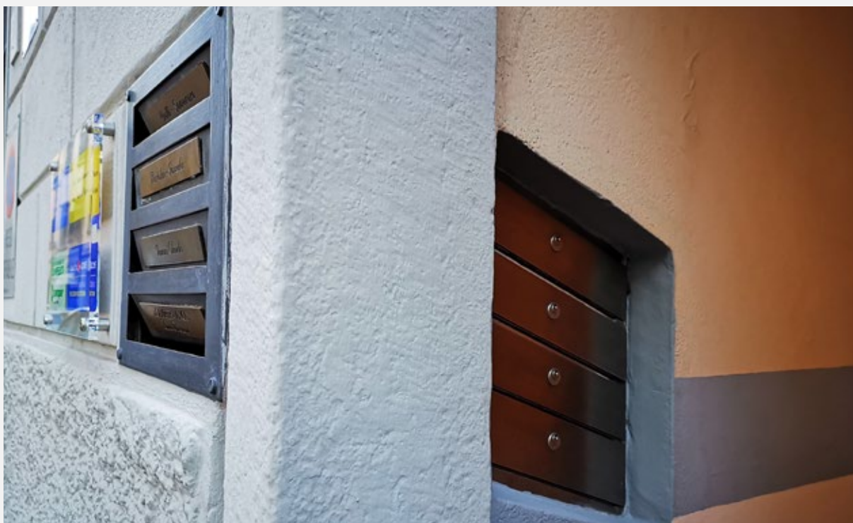
Vista angolo muro del box acciaio inox con cassette poste in orizzontale
