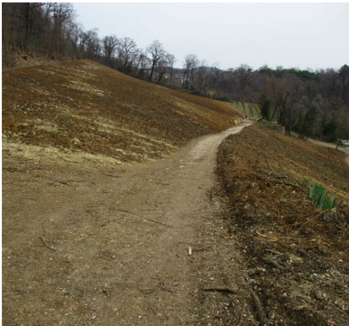
Disboscamento e nuova strada
