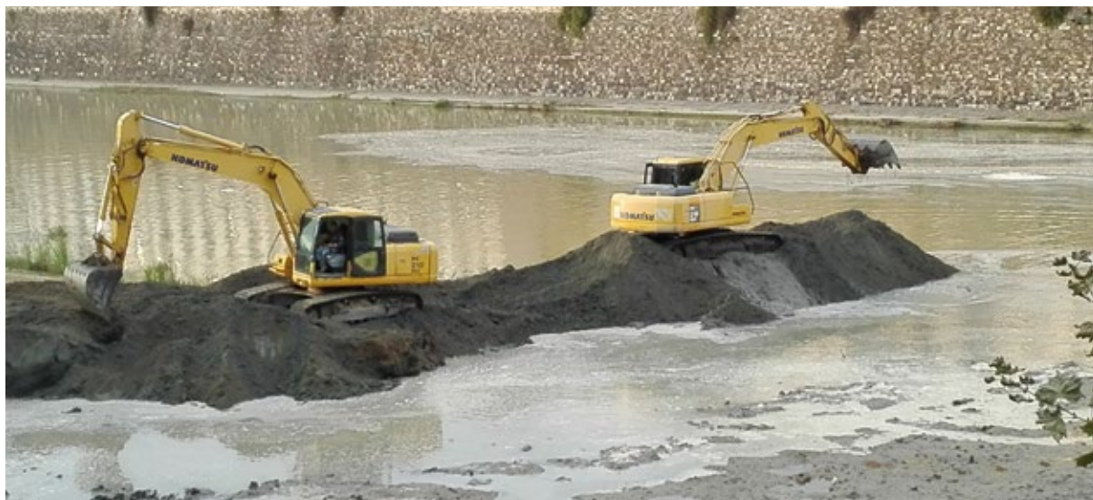
Firenze, fiume Arno di fronte a piazza Piave, movimento terra che aumenta l'altezza del letto del fiume
