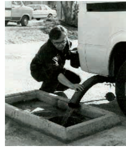
Il collegamento della prolunga all'impianto igienico-sanitario preposto a ricevere lo scarico delle acque reflue
