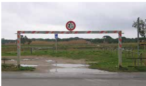
Esempi di impiego non corretto di sbarra ad altezza ridotta dalla sede stradale con divieto di transito per altezza
